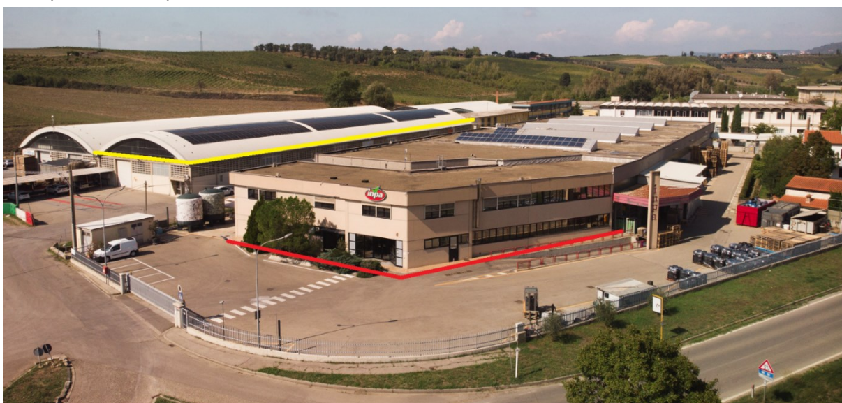
Figura 1: Il sito produttivo (unità 1 in rosso e unità 2 in giallo)
